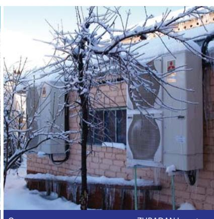
Отопление тепловыми насосами ZUBADAN Inverter
